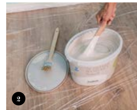
2 Προτού ξεκινήσετε θα πρέπει να ανακατέψετε πολύ καλά το χρώμα. Ανακατέψτε το τουλάχιστον για ένα με δύο λεπτά.
