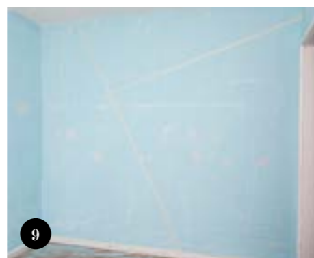
9 Το πρώτο τμήμα της επιφάνειας (εδώ κάτω δεξιά) έχει οριοθετηθεί με χαρτοταινία. Τώρα μπορείτε να αρχίσετε το βάψιμο.
