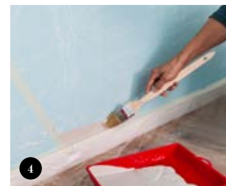
4 Πρώτα βάψτε με το πινέλο τις γωνίες των τοίχων, τις γωνίες στην οροφή και τις άκρες πάνω από το σοβατεπί.
