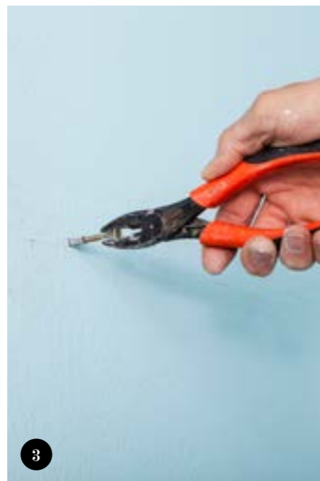
3 Τα ούπατ που ίσως υπάρχουν, μπορείτε να τα αφαιρέσετε εύκολα αν βιδώσετε μια βίδα και την τραβήξετε με την πένσα.
