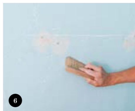
6 Στη συνέχεια καθαρίστε καλά τον τοίχο από τις σκόνες του τριψίματος, χρησιμοποιώντας μία βούρτσα.
