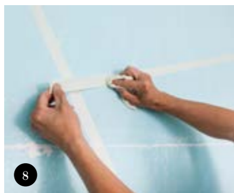
8 Κολλήστε την αρχή της χαρτοταινίας και συνεχίστε μέχρι το σημείο τέλους. Πιέστε με ένα πανί να κολλήσει καλά.
