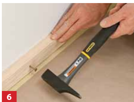
6 Αν κάνετε τη στερέωση με καρφωτό βύσμα, τοποθετήστε το στην τρύπα και χτυπήστε τη βίδα με το σφυρί.
