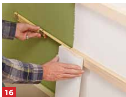
16 Ξεκινήστε με την τοποθέτηση της πρώτης πλάκας. Θα πρέπει να προεξέχει περίπου 4 εκ. από το καδρονάκι.
