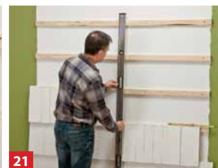
21 Ελέγχετε συνεχώς την ευθύγραμμη τοποθέτηση των πλακών και διορθώνετε τη θέση τους όπου χρειάζεται.
