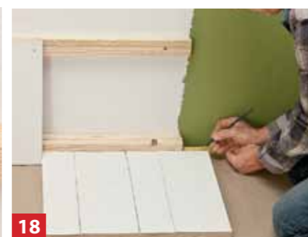
18 Συνεχίστε με τις υπόλοιπες πλάκες της πρώτης σειράς. Απλώστε τις 4-5 τελευταίες στο δάπεδο...
