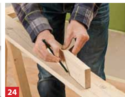
24 Προσαρμόστε πλευρικά τη σανίδα, αποτυπώστε τα τελειώματα των πλακών και σχεδιάστε το τελικό περίγραμμα.
