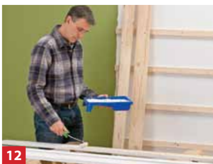
12 Βάψτε με λευκό ματ χρώμα τις καλά ξεραμένες σανίδες, ολόκληρες, όπως είναι, και αφήστε τις να στεγνώσουν.
