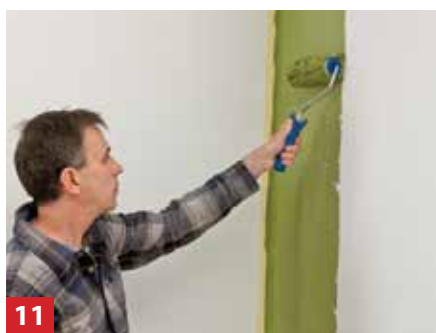
11 Συνεχίστε με το ρολό. Εδώ, με τη λευκή επένδυση συνδυάστηκε μία ψυχρή ματ απόχρωση Bamboo.
