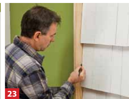
23 Αν κάποιο πλαινό του πάνελ είναι ορατό, θα πρέπει να «κλείσει» με μια κατάλληλα κομμένη σανίδα.
