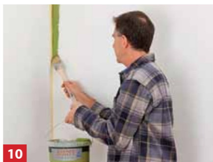
10 Και τώρα το βάψιμο των γειτονικών επιφανειών του τοίχου. Βάλτε χαρτοταινία και αρχίστε από τις άκρες με πινέλο.
