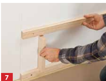
7 Συνεχίστε με την τοποθέτηση των επόμενων καδρονιών, χρησιμοποιώντας κατάλληλα κομμένους αποστάτες.
