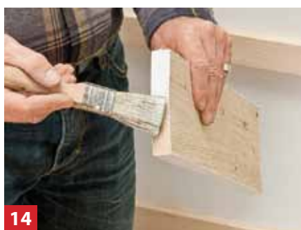
14 Σωστό είναι να βάψετε και τα σόκορα. Αυτό είναι απαραίτητο τουλάχιστον στις κάτω ακμές των πλακών.
