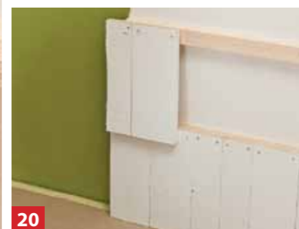
20 Τώρα συνεχίστε με τις επόμενες σειρές. Τα κεφάλια των καρφιών καλύπτονται από τις επόμενες πλάκες.
