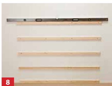
8 Ευθυγραμμίστε κατακόρυφα τις άκρες των καδρονιών και ελέγχετε συνεχώς την οριζοντιότητα με το αλφάδι.
