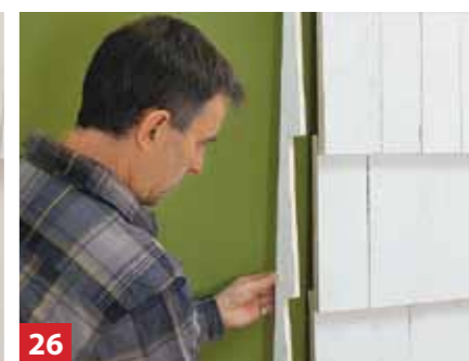
26 Περάστε το «κάλυμμα» πίσω από τις πλάκες και στερεώστε το με ακέφαλα καρφιά στα εσωτερικά καδρονάκια.
