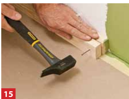
15 Για να τοποθετηθεί λοξά η πρώτη σειρά, θα πρέπει να υπάρχει ένα δεύτερο καδρονάκι στο κάτω μέρος.
